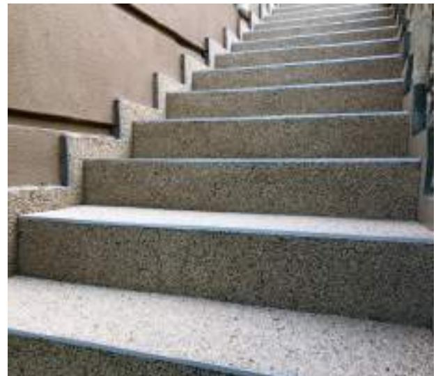
Fox Stonecarpet®, farklı renk ve boyutlardaki doğal agregaların Fox Stonecarpet® bağlayıcıyla karıştırılması ile hazırlanan, çeşitli kalınlıklarda uygulama imkanı sağlayan bir zemin kaplama sistemidir.
