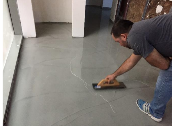
Şekil 6 Fox Purathane Topcoat WB Şeffaf Mat / Fox Epothane Basecoat Clear Uygulaması
