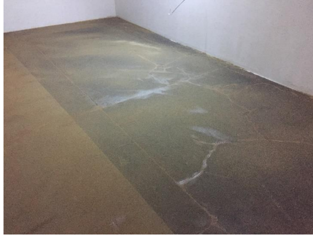
Şekil 1 Epoksi Astar Zemin Uygulaması
