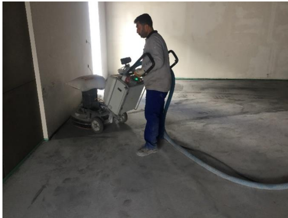
Şekil 6 Kuru Elmas Silim Uygulaması
