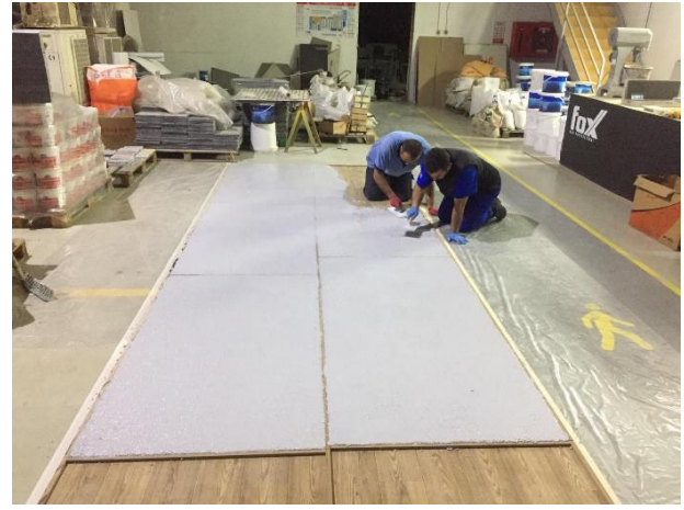
Şekil 5 Fox Epothane Basecoat Terrazzo Uygulaması
