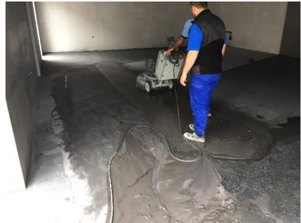
Şekil 7 Sulu Elmas ve Reçine Ped Uygulaması
