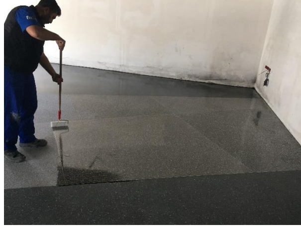
Şekil 8 Fox Domino® PU Sealer FD793 Uygulaması
