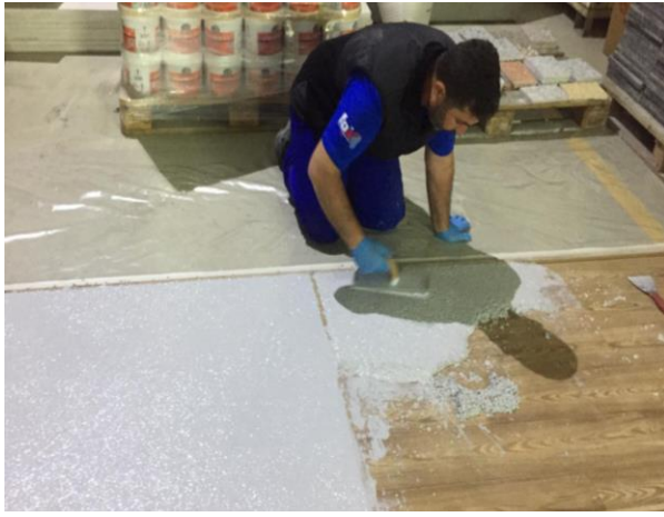
Şekil 4 Fox Epothane Basecoat Terrazzo Uygulaması
