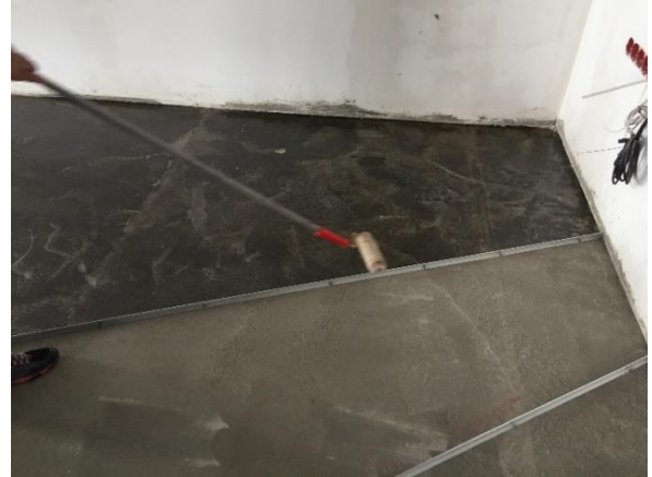
Şekil 2 Epoksi Astar Uygulaması
