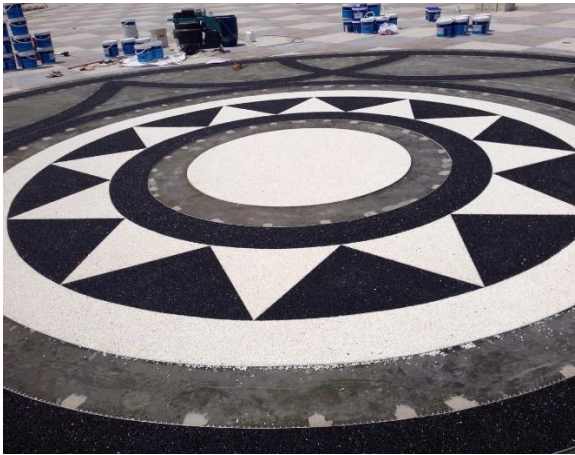
Рисунок 3 Нанесение Fox Stonecarpet® EP Смеси
