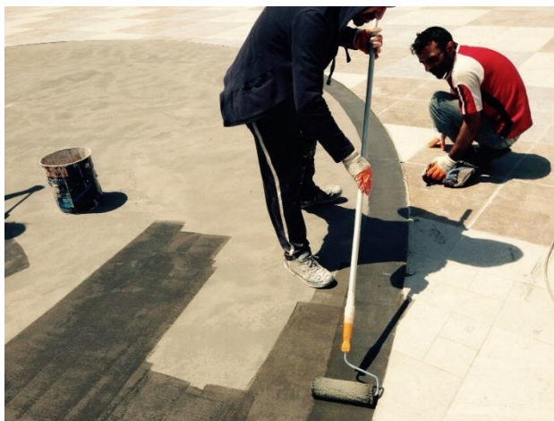
Рисунок 1 Нанесение Эпоксидной Грунтовки
