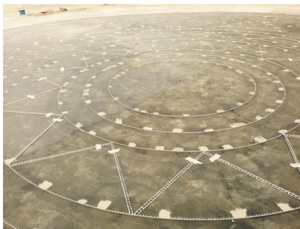
Рисунок 2 Нанесение Эпоксидной Грунтовки
