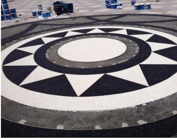
Şekil 3 Fox Stonecarpet® Agrega Karışımı Uygulaması
