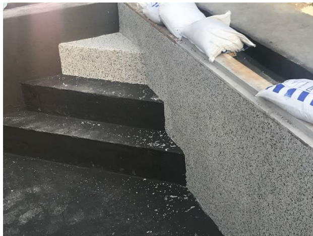
Рисунок 1. Нанесение Эпоксидной Грунтовки на Пол
