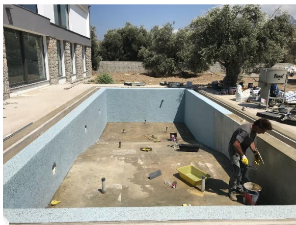
Рисунок 2. Нанесение Эпоксидной Грунтовки на Стены
