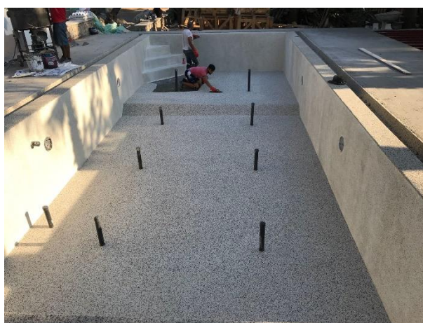
Рисунок 4. Нанесение Смеси FOX STONECARPET® EP и наполнителя
