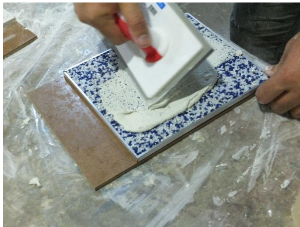
Рисунок 8. Нанесение Fox Epoxyfuga FX142 Pebble
