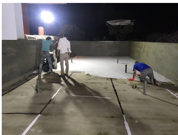
Рисунок 3. Нанесение Смеси FOX STONECARPET® EP и наполнителя
