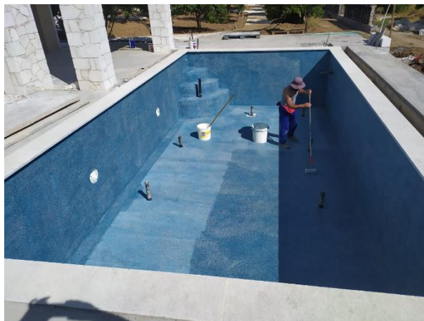
Рисунок 9. Нанесение FOX DOMINO® PU SEALER FD793
