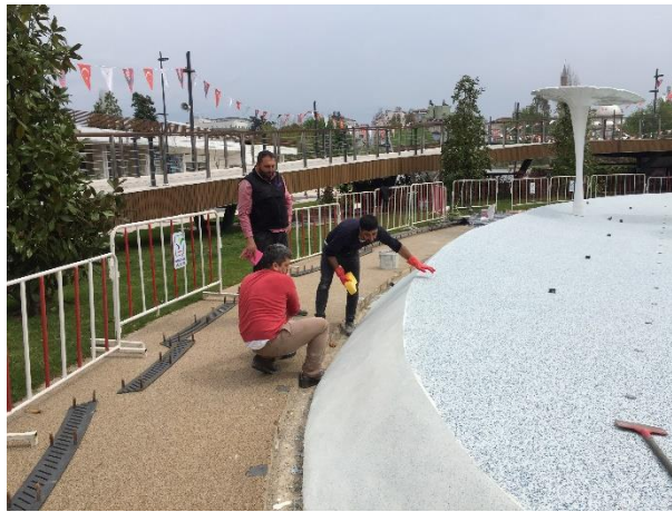
Рисунок 7. Нанесение Fox Epoxyfuga FX142 Pebble
