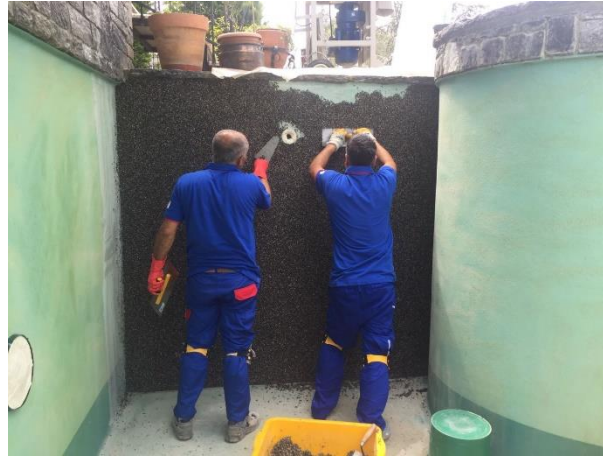
Рисунок 5. Нанесение Смеси FOX STONECARPET® T и AGREGA
