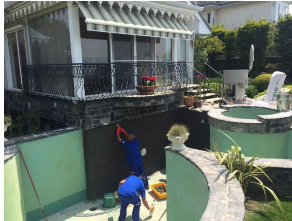
Рисунок 6. Нанесение Смеси FOX STONECARPET® T и AGREGA
