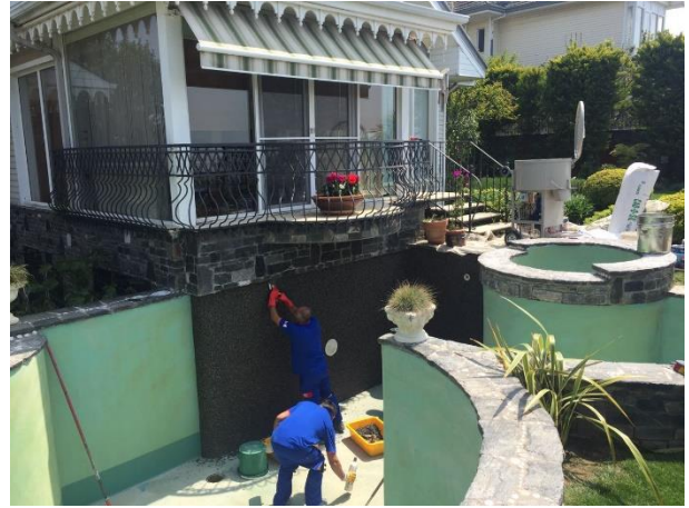
Şekil 6 Fox Stonecarpet® T Agregası Uygulaması
