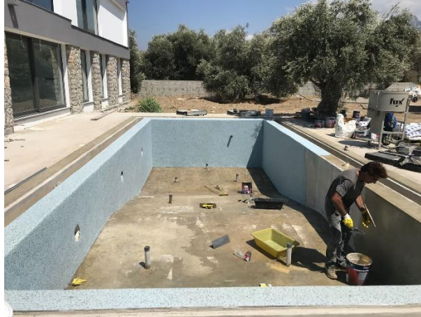
Şekil 2 Epoksi Astar Duvar Uygulaması
