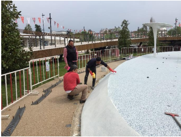
Şekil 7 Fox Epoxyfuga FX142 Pebble Uygulaması
