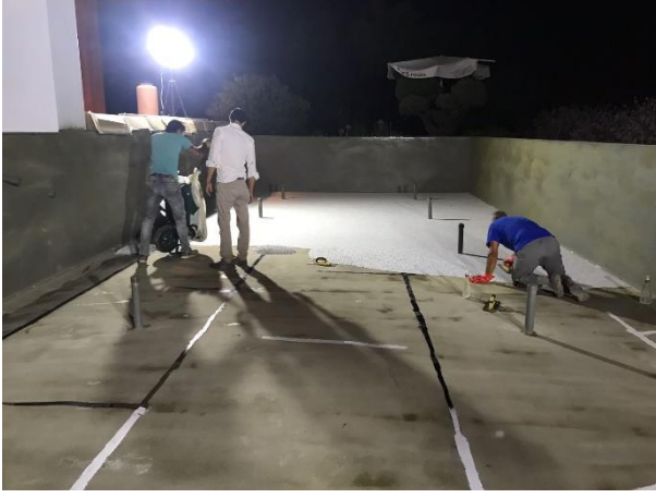
Şekil 3 Fox Stonecarpet® EP Agregası Uygulaması
