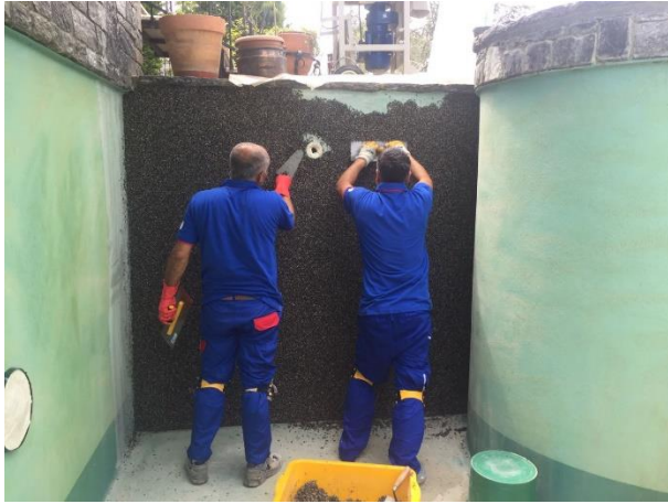
Şekil 5 Fox Stonecarpet® T Agregası Uygulaması
