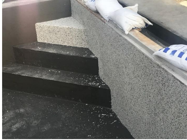
Şekil 1 Epoksi Astar Zemin Uygulaması
