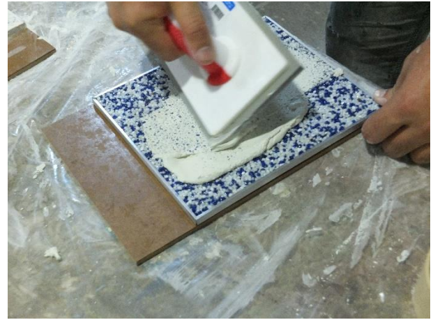
Şekil 8 Fox Epoxyfuga FX142 Pebble Uygulaması
