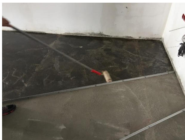
Рисунок 2. Нанесение Эпоксидной Грунтовки
