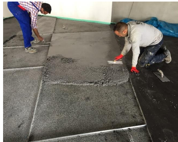
Рисунок 5. Нанесение FOX DOMINO PLUS FD772
