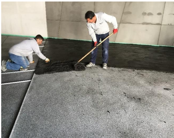
Рисунок 4. Нанесение FOX DOMINO PLUS FD772
