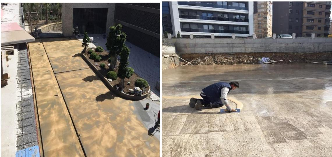
**ВАЖНОЕ ПРИМЕЧАНИЕ:** В случаях, когда капиллярные трещины, которые могут возникнуть в структуре бетона, заполнены и поверхность пористая, перед нанесением **FOX EPOXYHANE® PRIMER** необходимо нанести пропитанную грунтовку с помощью **FOX EPOXYHANE® PRIMER SL**. **FOX EPOXYHANE® PRIMER FL** следует наносить для устранения поверхностных дефектов и для гладкой поверхности.
