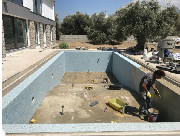
Şekil 2 Epoksi Astar Duvar Uygulaması
