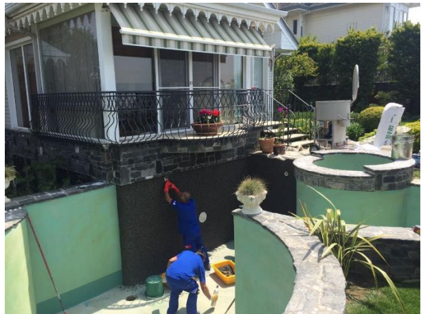
Şekil 6 Fox Stonecarpet T Agregası Uygulaması
