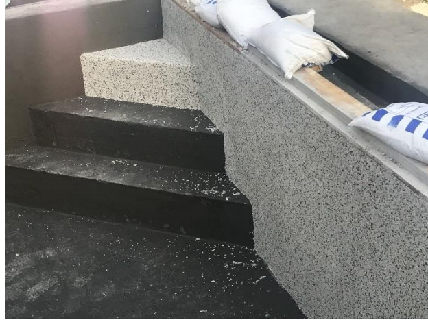
Şekil 1 Epoksi Astar Zemin Uygulaması
