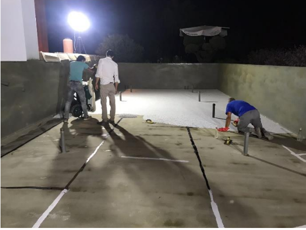
Şekil 3 Fox Stonecarpet EP Agregası Uygulaması
