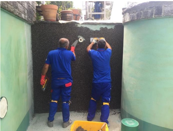
Şekil 5 Fox Stonecarpet T Agregası Uygulaması
