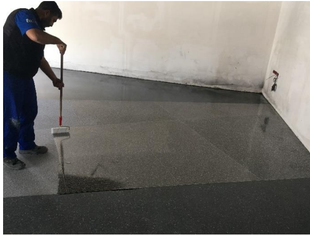
Şekil 8 Fox Domino PU Sealer FD793 Uygulaması
