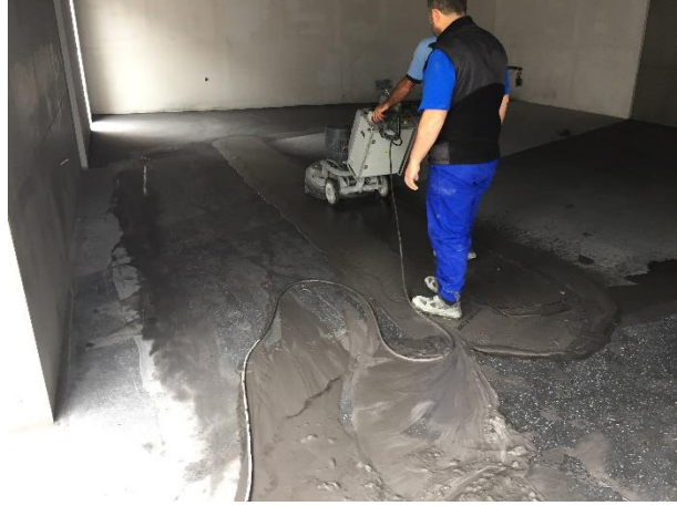
Şekil 7 Sulu Elmas ve Reçine Ped Uygulaması
