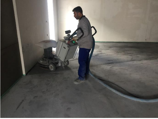
Şekil 6 Kuru Elmas Silim Uygulaması
