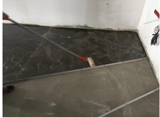
Şekil 2 Epoksi Astar Uygulaması
