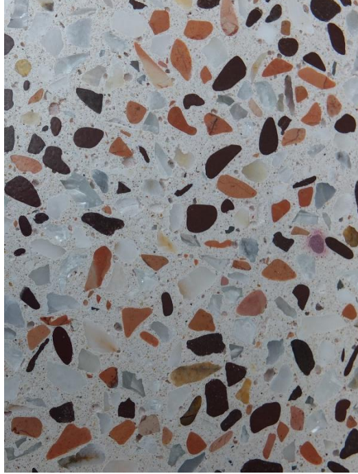
Şekil 9 Purathane Topcoat WB Uygulaması
