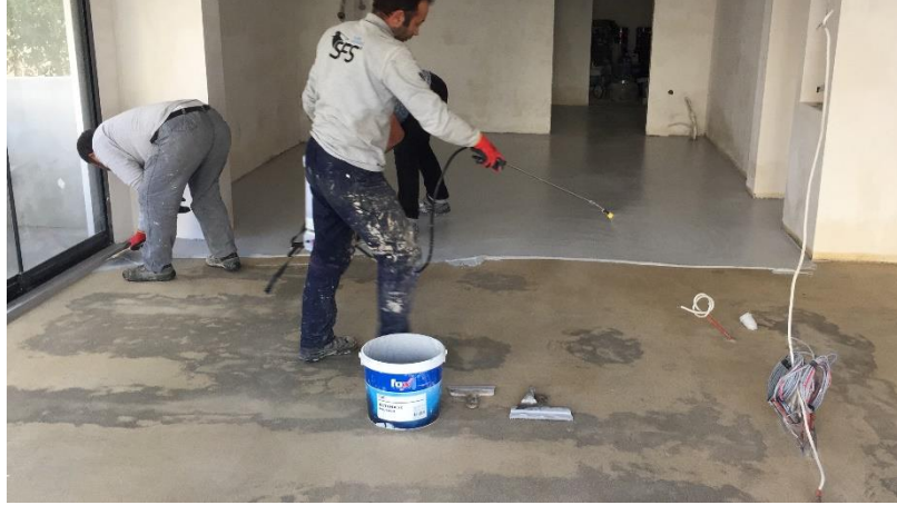
Şekil 3 Betonage Basecoat BC Uygulaması Öncesi Nemlendirme
