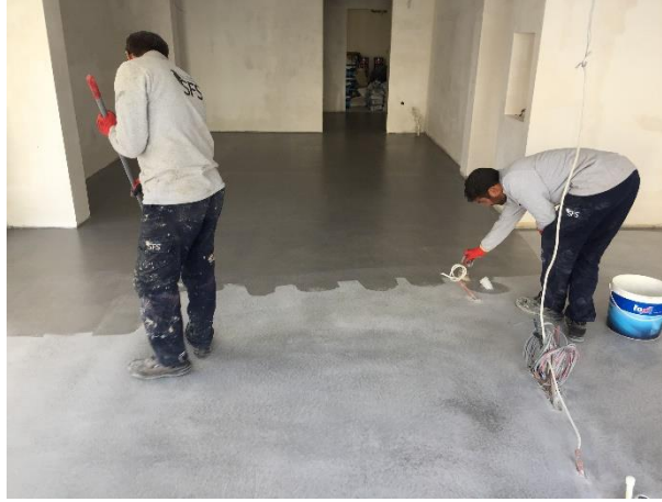
Şekil 13 Purathane Topcoat WB Uygulaması
