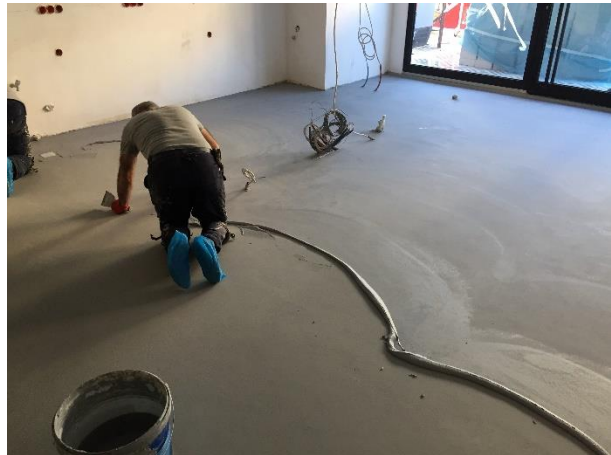
Şekil 10 Betonage Basecoat FC 2.Kat Uygulaması
