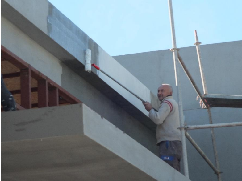
Şekil 4 Düşey Yüzey Betonage Basecoat BC Uygulaması Öncesi Astarlama
