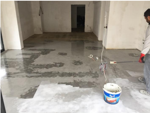
Şekil 1 Epoksi Astar Uygulaması
