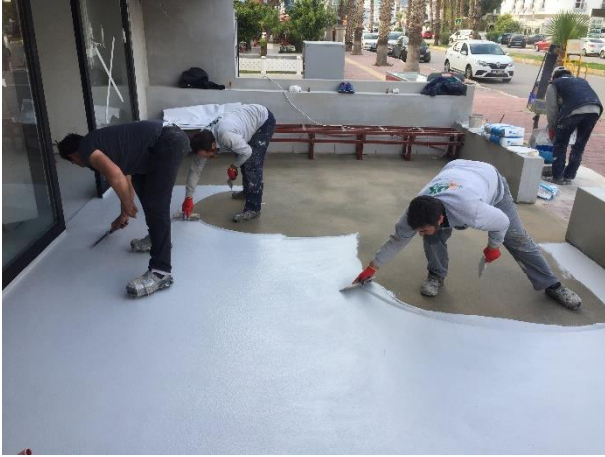
Şekil 5 Betonage Basecoat BC 1.Kat Uygulaması
