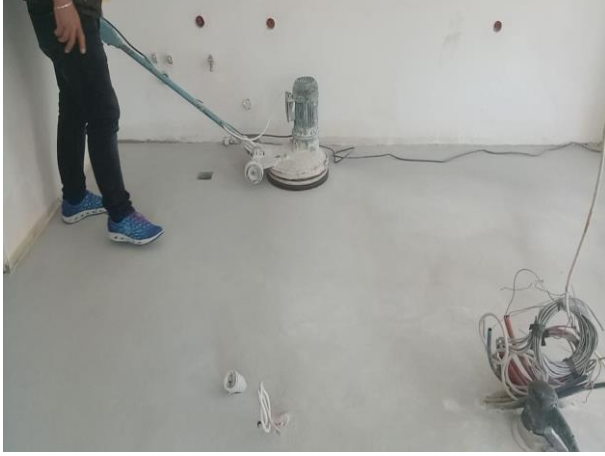
Şekil 7 2.kat Betonage Basecoat BC Sonrası Zımparalama
