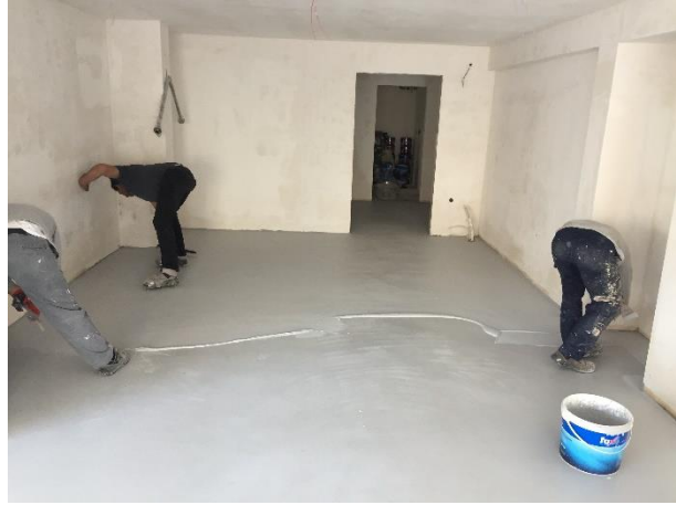
Şekil 6 Betonage Basecoat BC 2.Kat Uygulaması
