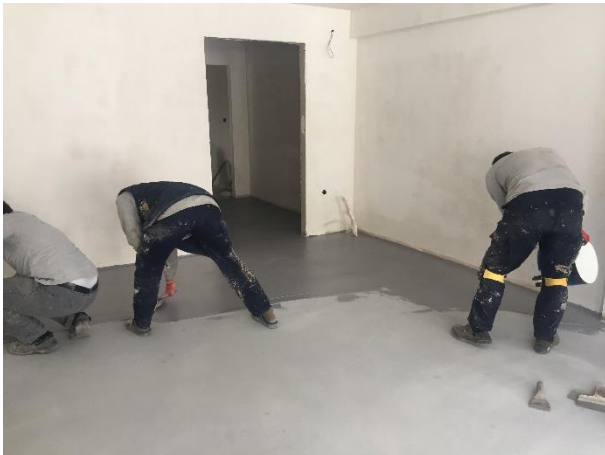
Şekil 9 Betonage Basecoat FC 1.Kat Uygulaması
