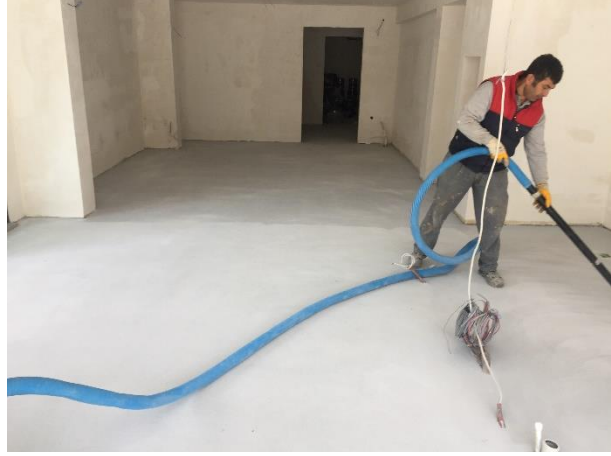
Şekil 8 Zımpara Sonrası Temizlik İşlemi
