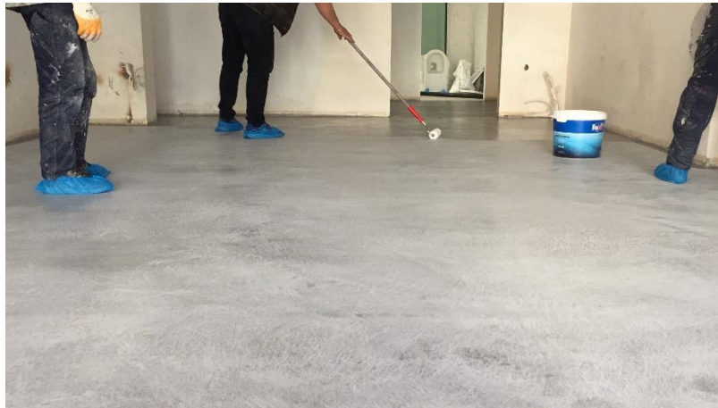
Şekil 12 Domino AC Sealer FD791 Uygulaması
