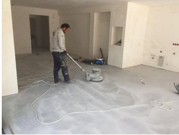
Şekil 11 2.kat Betonage Basecoat FC Sonrası Zımparalama
